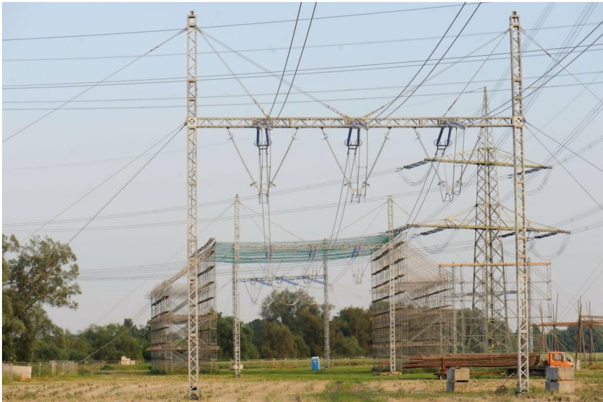
Abbildung 9 Einsatz von Provisorien: 380-kV-Freileitungsprovisorium für ein System, mit errichtetem Schutzgerüst (Hintergrund)
